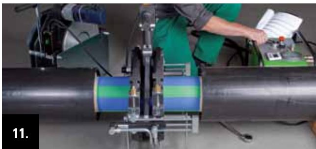
11. Montageschlitten durch Betätigung der Hydraulik langsam an das Schweißschwert heranfahren und Rohrenden bis zur Erreichung des vorgegebenen Angleichdrucks an das Schweißschwert drücken.
