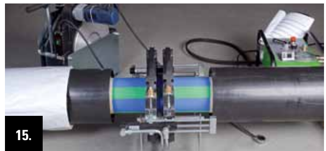
15. Bis zum Ende der Abkühlzeit bleibt der Montageschlitten auf dem an der Hydraulik eingestellten Schweißdruck.
