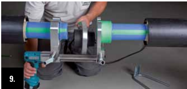
9. Nach Ablauf der Anwärzeit Zugwerkzeug auseinanderfahren und Schweißgerät zwischen Rohrende und Formteil entfernen.
