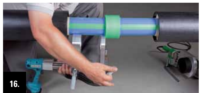
16. Spannbacken des Zugwerkzeuges soweit öffnen, dass das Zugwerkzeug seitlich oder nach unten von der Verbindungsstelle entfernt werden kann.
