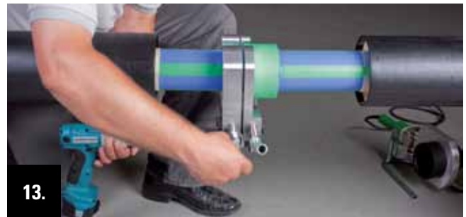
13. Nach Ablauf der Abkühlzeit Spannbacken auf der Rohrseite durch Losdrehen der Befestigungsschraube lösen.
