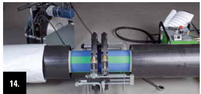
14. Durch Betätigung der Hydraulik werden die Rohrenden langsam bis zur Erreichung des erforderlichen Schweißdrucks zusammengefügt.
