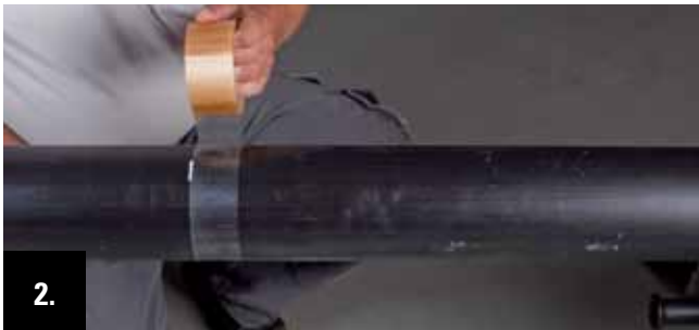
2. Schnittlinie mit einem Klebeband auf dem Rohrumfang markieren.
