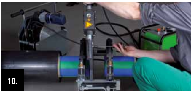
10. Schweißwerkzeug zwischen den Rohrenden einsetzen, Schweißschwert auf Sauberkeit überprüfen und Schweißtemperatur messen.
