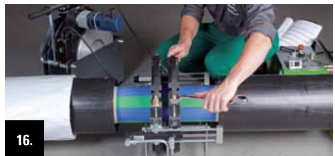
16. Nach Ablauf der Abkühlzeit wird an der Hydraulik der Druck abgelassen. Anschließend werden die Spannelemente gelöst und die Spannvorrichtung entfernt.
