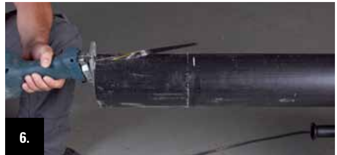
6. Mantel mit handelsüblicher Tigersäge oder Fuchsschwanz mit Sägeblatt für Kunststoff bis auf PUR-Isolierschicht aufschneiden.
