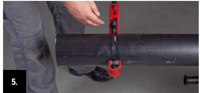
5. Mantelrohr mit Rohrabschneider bis zur PUR-Isolierschicht auf gesamtem Rohrumfang durchtrennen.
