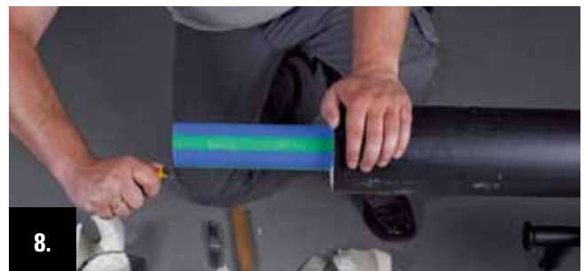
8. Abisoliertes Mediumrohr reinigen und Rohrende sowohl von innen als auch von außen entgraten.
