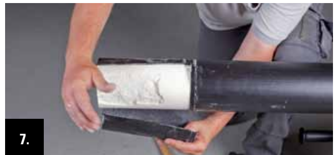
7. Mantelrohrende abtrennen und anschließend PUR-Isolierschicht auf ganzer Abisolierlänge mechanisch entfernen.
