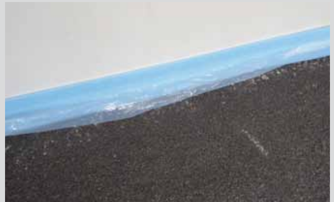
Verlegung des Randdämmstreifen
