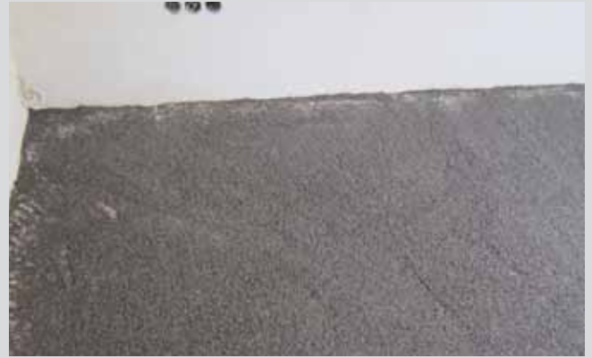
Bei Bodenunebenheiten Höhenausgleich durch Schüttung
