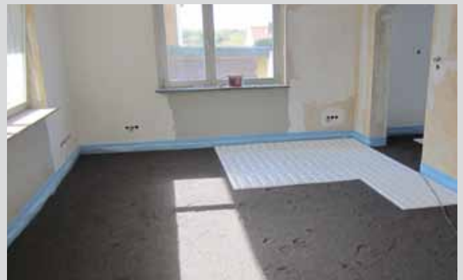
Verlegung der Systemelemente
