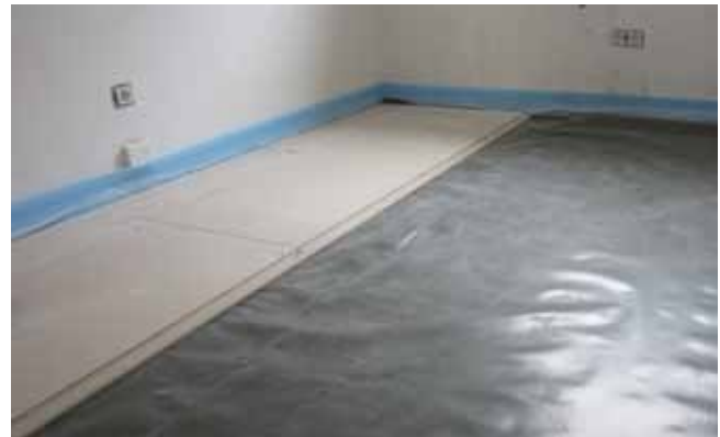
Vor Einbau der Trockenelemente wird eine Trennfolie aus PE verlegt.
