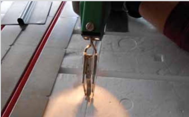
Erforderliche zusätzliche Rohrkanäle für z.B. Anbindelungen werden per Glühfadenschneider erstellt.
