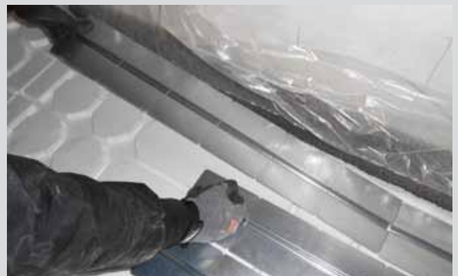
Einbau der Wärmeleitmodule
