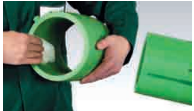
Reinigen der E-Muffen Innenfläche
