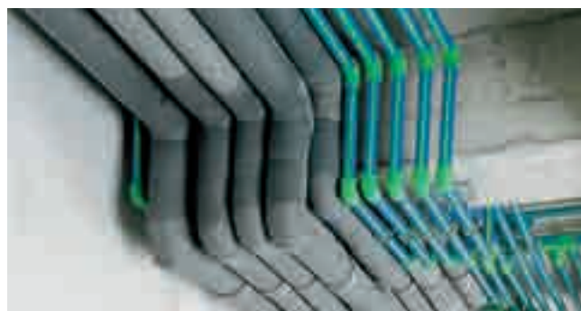
Die Steig- und Verteilungsleitungen für die Heizungsversorgung sollten in climatherm-Verbundrohren geplant und ausgeführt werden.
