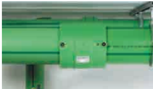
Einschieben des zweiten, ebenfalls vorgeschälten und gereinigten Rohres in die Muffe
