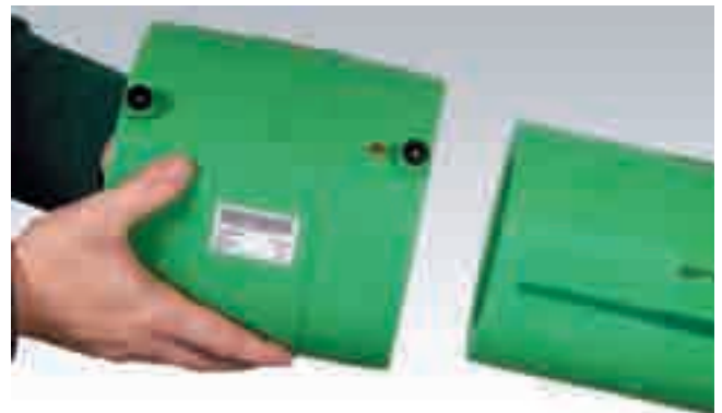
Aufschieben der E-Muffe auf das Rohrende
