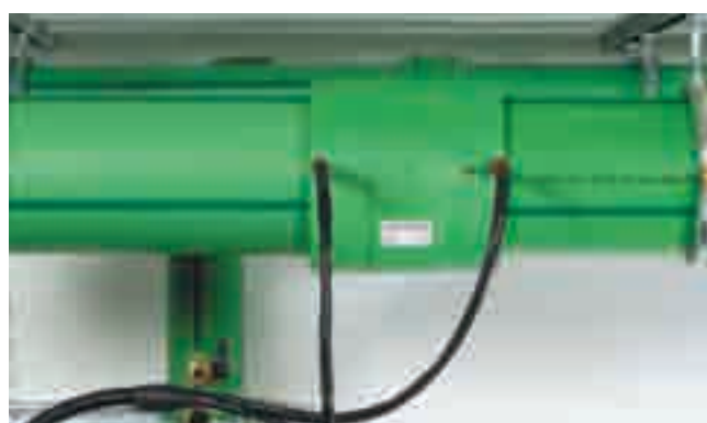
Schweißgerät auf Muffendurchmesser einstellen. Schweißvorgang starten. Abkühlzeit einhalten. Fertig!
