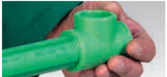
... Ausrichten der Formteile.
