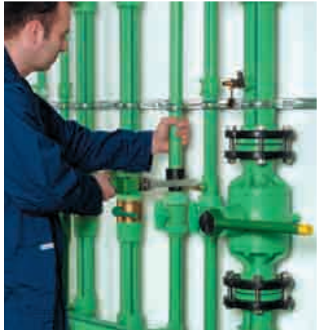
Verteilerbau mit fusiotherm®- und climatherm- Faserverbund-Rohren und großem Kugelhahn
