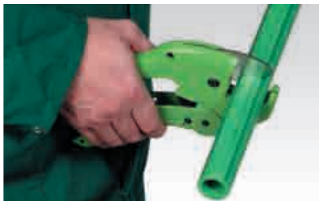
Abschneiden des Rohres
