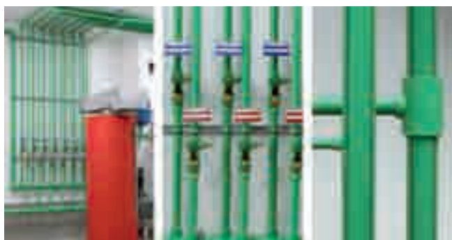
...über die Steigleitungen, ausgelegt in fusiotherm®-Verbund-Rohr, mit konventionellem Etagenabgang oder Etagenverteilung im Anbindeverfahren,...
