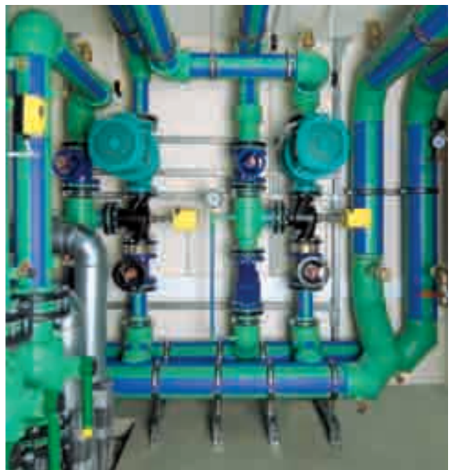
Verteilerbau mit fusiotherm®- und climatherm- Faserverbund-Rohren und großem Kugelhahn
